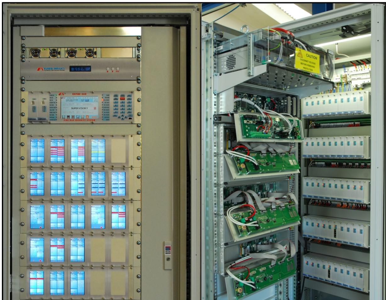
La EXFIRE360 è caratterizzata da un armadio ad apertura frontale delle dimensioni predeterminate di 2000 (h) x 800 (L) x 800 (P) mm, L'armadio è completo di zoccolo 100mm ed è costituita da un rack di base per CPU, Rack porta schede; Rack porta frontalini. Sia il rack per il display principali che per quelli secondari sono montati sulla porta anteriore del quadro e ruotano con essa liberando l'accesso alla zona collegamenti e alimentatore.
